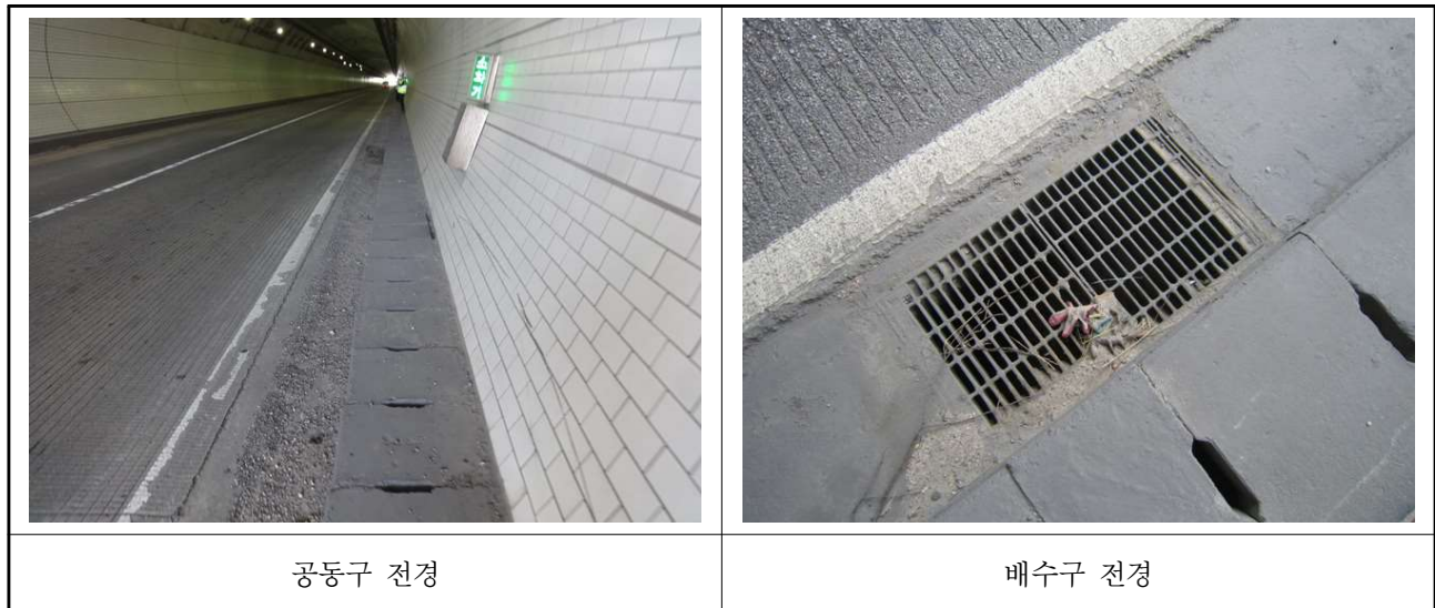
【사진 3.11】 공동구 및 측구(배수로) 전경
