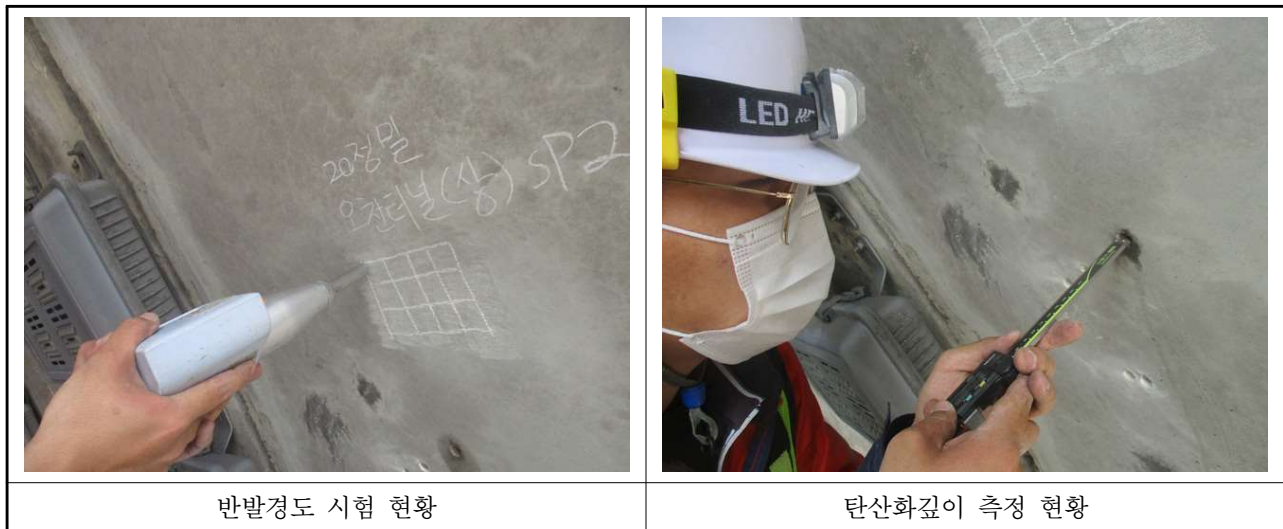
【사진 3.17】 콘크리트 내구성조사 현황
