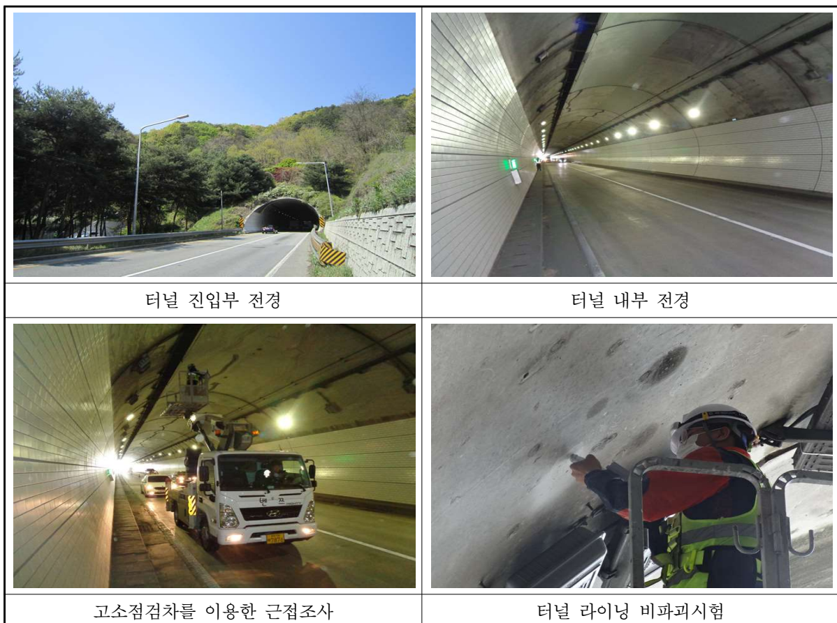
【사진 3.2】 근접조사를 위한 장비 사용 전경
