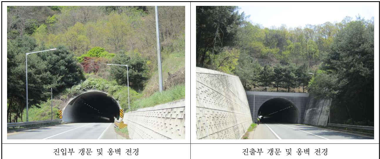
【사진 3.7】 갱문 시·종점부 전경
